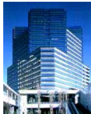
高層ビルにアルミカーテンウォール
