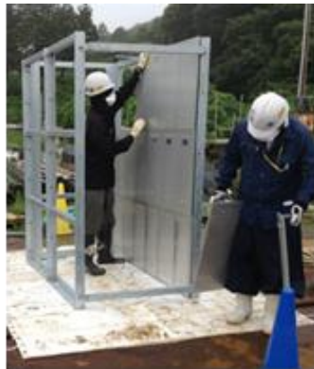
遮へい材の設置状況
